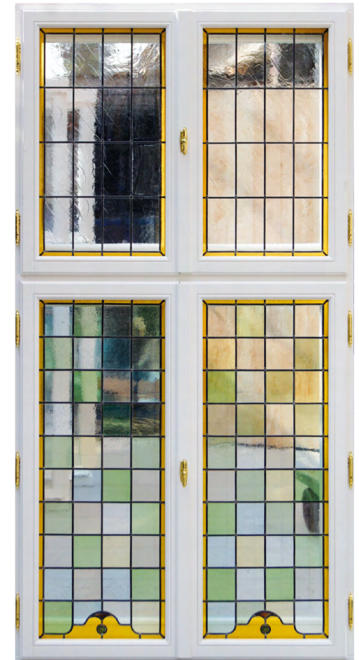
Une nouvelle fenêtre à deux bords dormants avec un vitrail rénové
