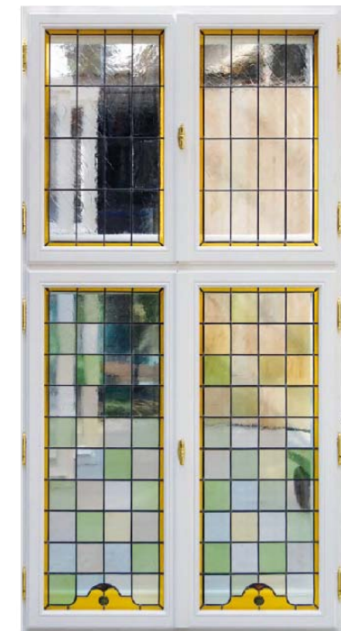
Stilisiertes Kastenfenster mit Bleiverglasungen
